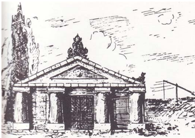
A PARASZTSZÍNHÁZ HOMLOKZATA
